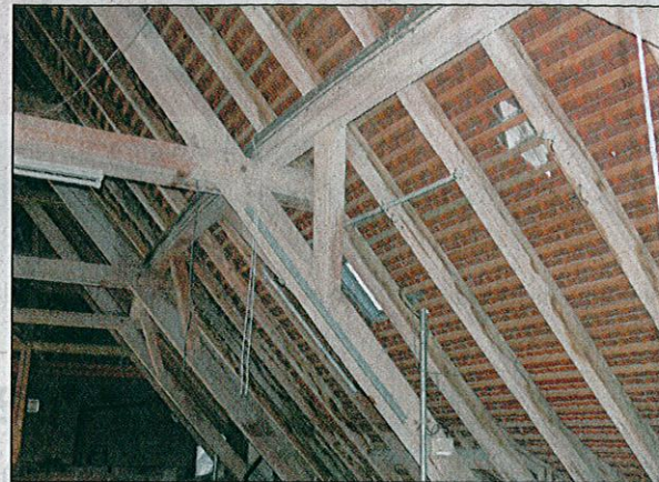
An der Pfette erkennt man, dass die Feuerwache ein Rundbau ist – damals eine architektonische Finesse des Stadtbaurats Blümer, der das Gebäude erstellte. Hier im Dach entstehen Loftwohnungen, Richtung Altstadt wird das Dach für Balkone geöffnet.
